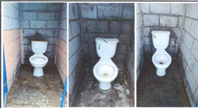
Foto 10: Sustitución Piso Antideslizante y azulejo en Sanitarios 1, 2 y 3
