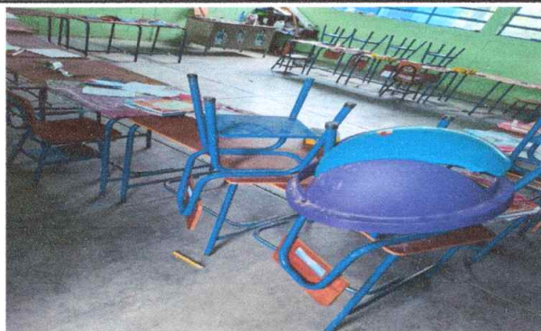
Foto 7: Sustitución de piso cerámico en Aula 2
