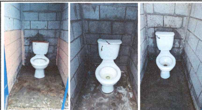
Foto 9: Sustitución de Inodoros en sanitarios 1, 2 y 3
