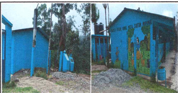
Foto 11: Reparación de muro perimetral de block y malla galvanizada
