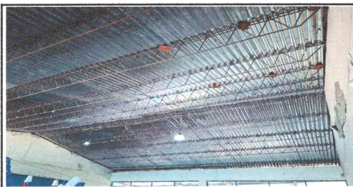
Foto 5: Sustitución de estructura de soporte de metal, por metal en Modulo 1
