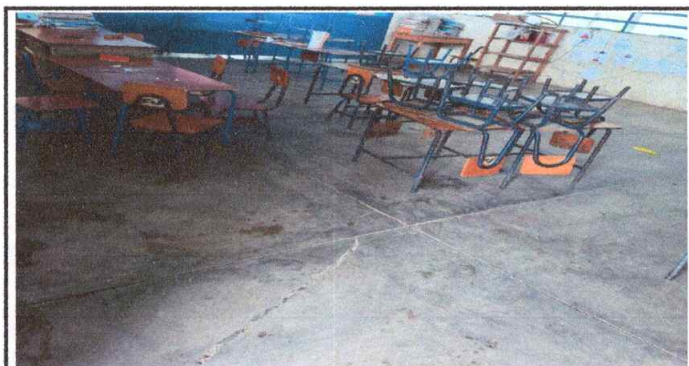
Foto 6: Sustitución de piso cerámico en Aula 1
